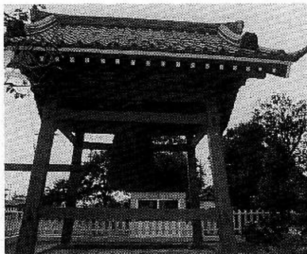
清浄院・鐘楼
