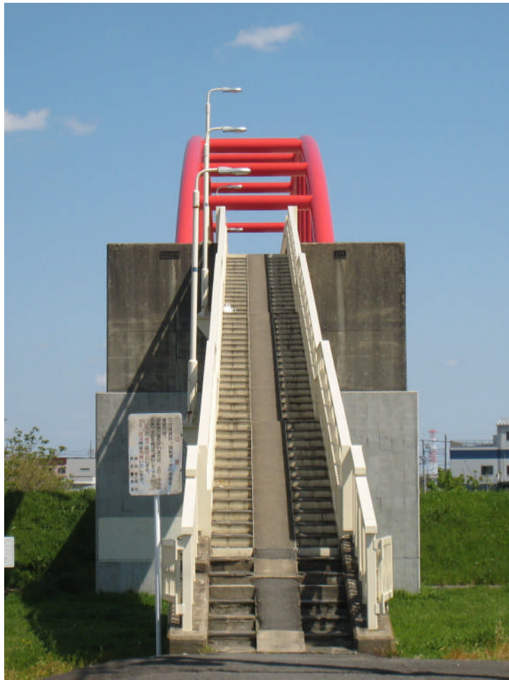
↑写真：「新中川水管橋」
