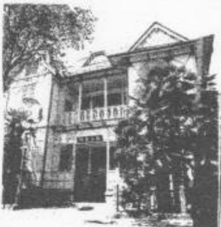
北欧海岸の建築物をモデルに、大正2年(1913)に、木と木を巧に組み合わせた「ハーフィンバー」という洋式で建てられた。屋根は雪を考慮して急勾配の造りで、土台は巴波川の水害を考慮して高くなっている。
