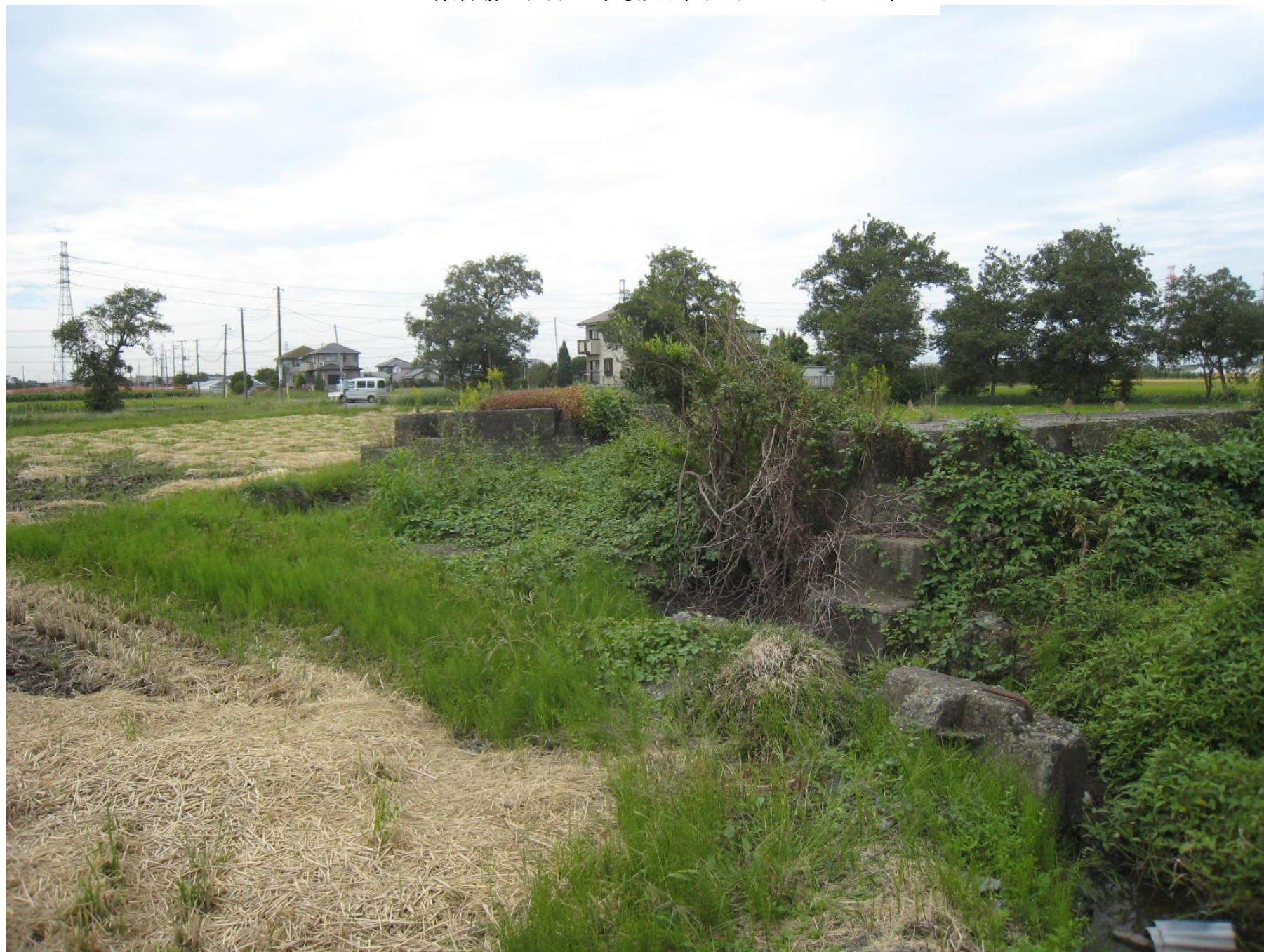
飛行場の西方に今も残る巨大なコンクリート台
