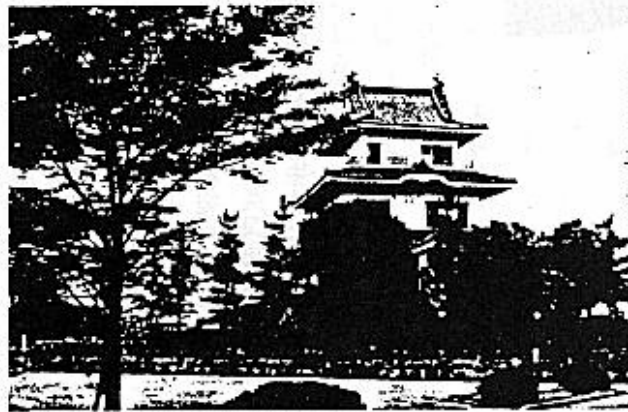
騎西城跡に建てられた天主閣(婦人金館)
