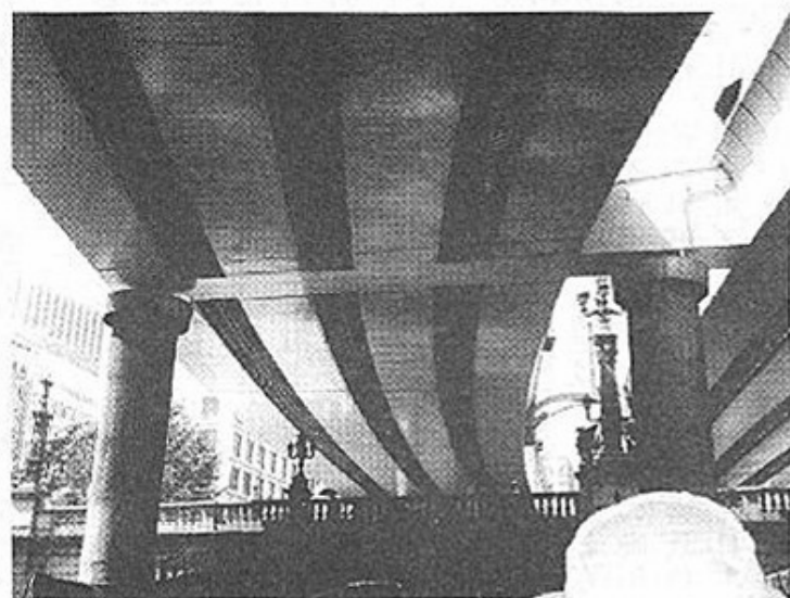
船から見る日本橋と高速道路
