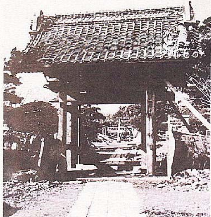
関東大震災で被災した迎攝院山門 奥に倒壊した本堂が見える
